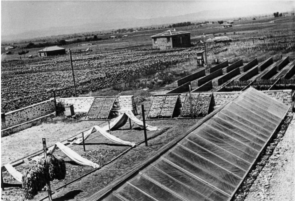
23-7-59: Γενική άποψις Ξηραντηρίου (ηλιάστρας), Καπνικού Σταθμού Αγρινίου, διάφοροι τρόποι ξηράνσεως καπνών.
