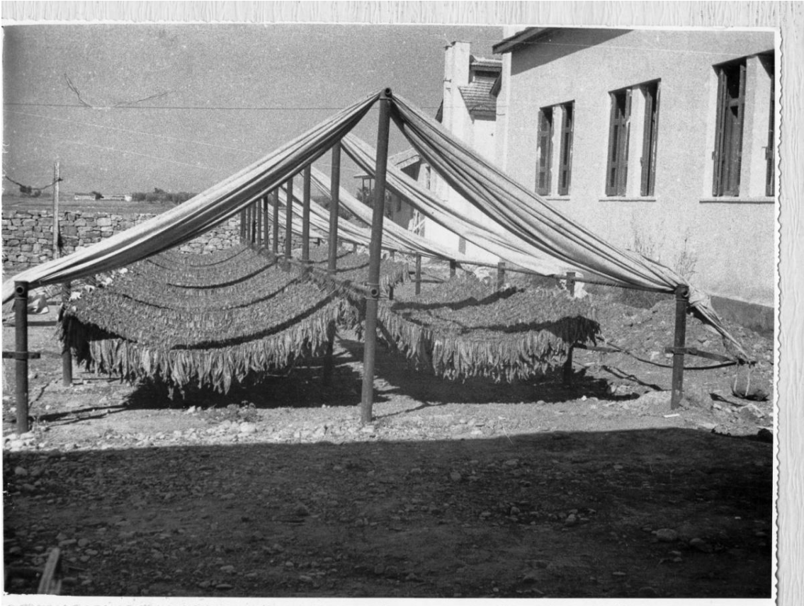
Παλαιόν Ξηραντήριον Καπνιστοῦ Σταδίου Ἀγρινίου Βραδείας ἀφουδατώσεως χλωρῶν μακροφύλλων < δώδεκα ἡμέραι διὰ πλήρη Ξήρανσιν >
