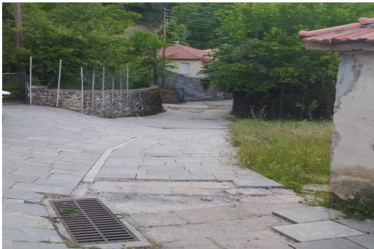
Εικόνα 2.10 Υφιστάμενη κατάσταση πλακοστρωμένης οδού.
