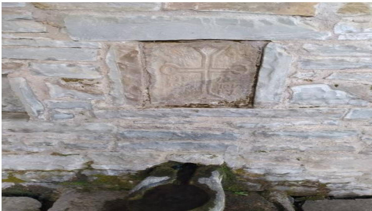
Εικόνα 2.7 Επιγραφή χρονολογίας 1893 κατά την κατασκευή της Κρήνης
