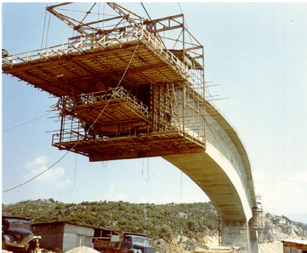
Εικόνα 4.8 Νέα Γέφυρα της Τατάρνας – κατασκευή του καμπύλου τμήματος ΑΒ (Πηγή: Οικονόμου, Αρίσταρχος. 1980. Η Στατική Των Κατασκευών , Μέρος Α)
