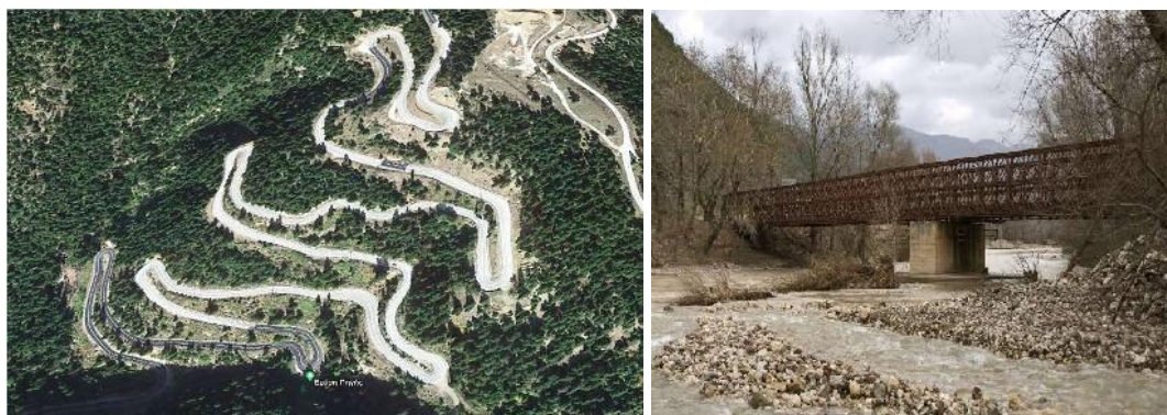
Εικόνα 12. Ελιγμοί στην υπάρχουσα Ε.Ο. και Γέφυρα bailey στον π. Μέγδοβα
