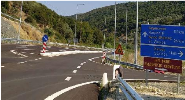
Βελτίωση παλαιού δρόμου - κόμβος προς Σχίνο και ασφαλτοστρωμένο τμήμα έως το 7 ο Km
